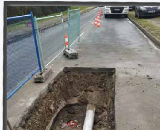
Travaux de réhabilitation du réseau d'assainissement Av. du Desclaud et réparation d'une partie effondrée.
