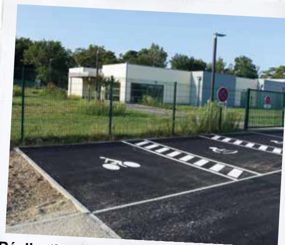
Réalisation d'un enrobé sur le parking de la salle multisports de Pétrus. Il reste à poser les racks à vélo.
